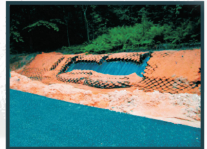
Przykład splywu powierzchniowego zle zamontowanej geokraty
