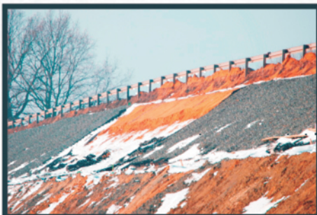
Przykład splywu powierzchniowego zle zamontowanej geokraty
